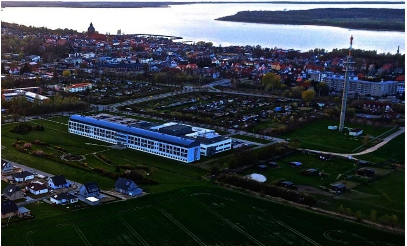
Abbildung: Luftaufnahme Krankenhaus Bodden-Kliniken Ribnitz-Damgarten GmbH
